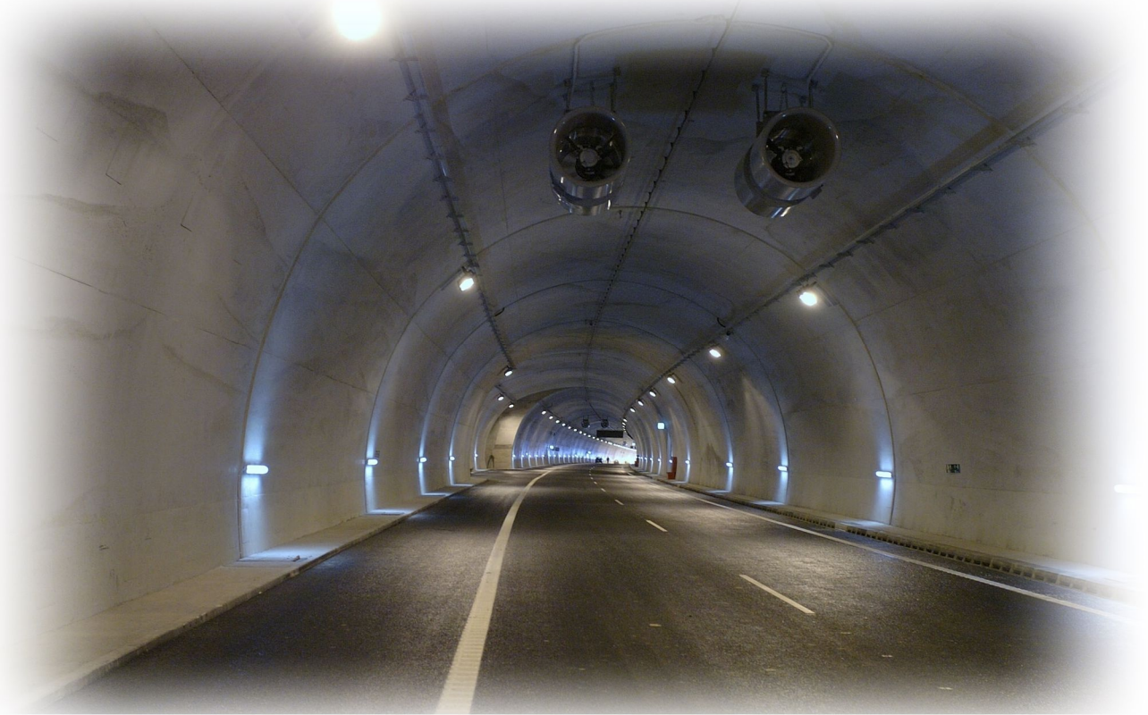
TÚNELES, MINERÍA, ATMÓSFERAS EXPLOSIVAS
